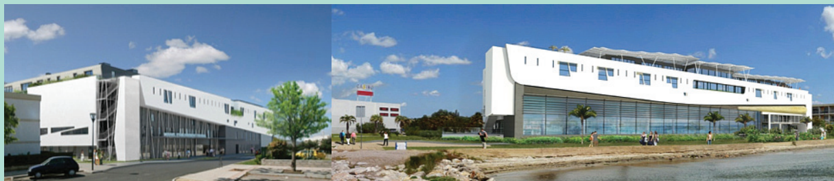
FIGURE 1 : Nouvel établissement thermal de Balaruc-les-Bains.
