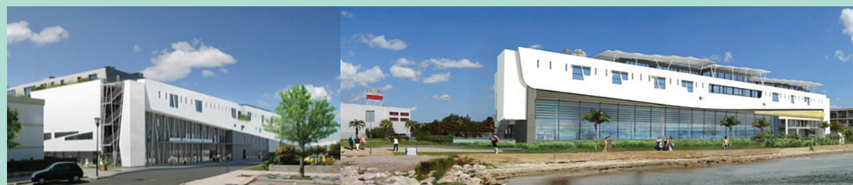
FIGURE 1 : Nouvel établissement thermal de Balaruc-les-Bains.
